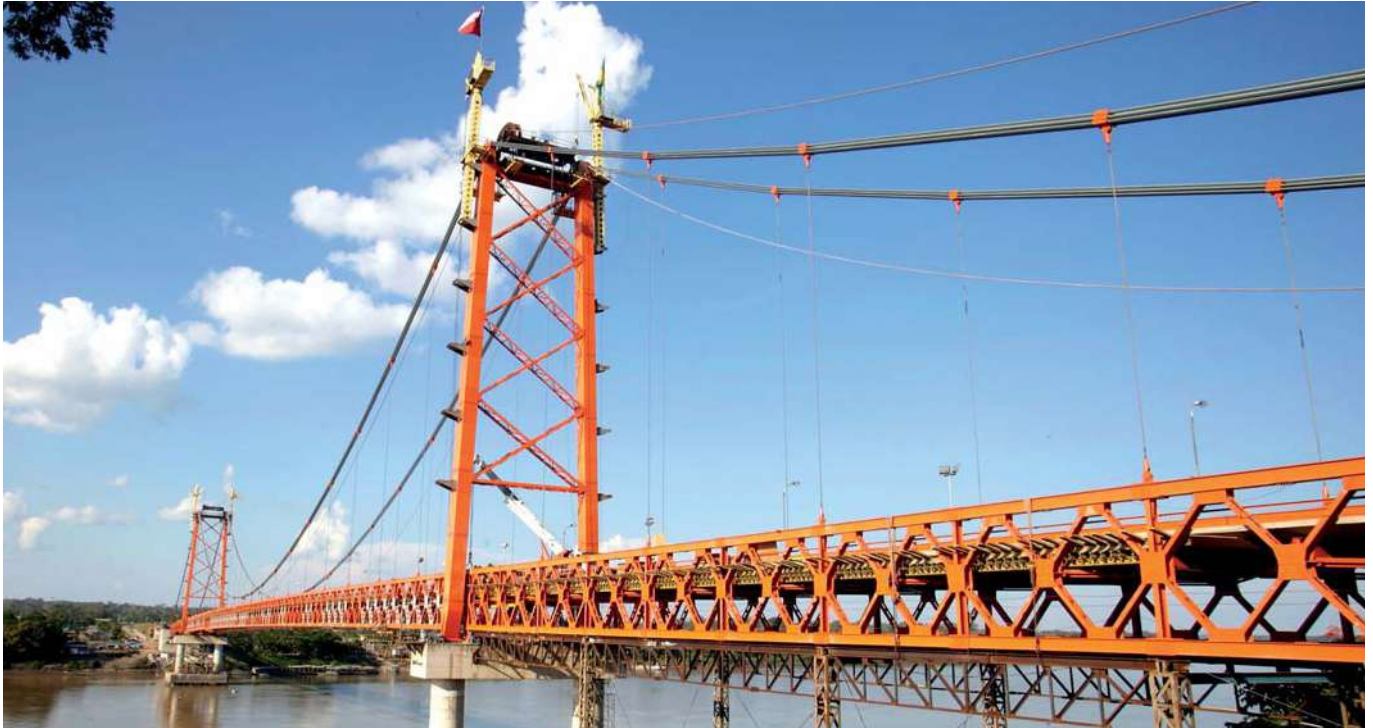
PUENTE BILLINGHURTS, 723 m. SUPERVISIÓN DE DISEÑO Y OBRA.
