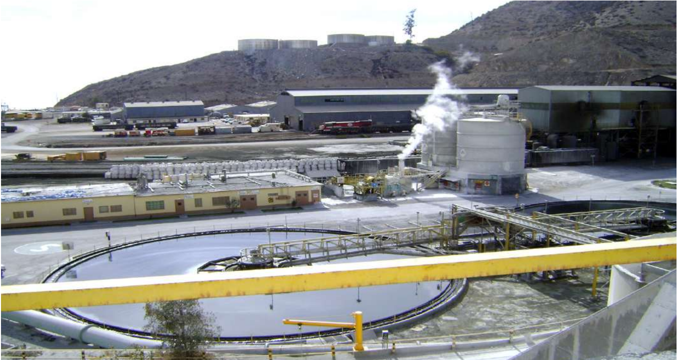
AMPLIACIÓN TOQUEPALA A 100,000 TMPD. INGENIERÍA DE DETALLE Y GESTIÓN DE SUMINISTRO. TACNA.
