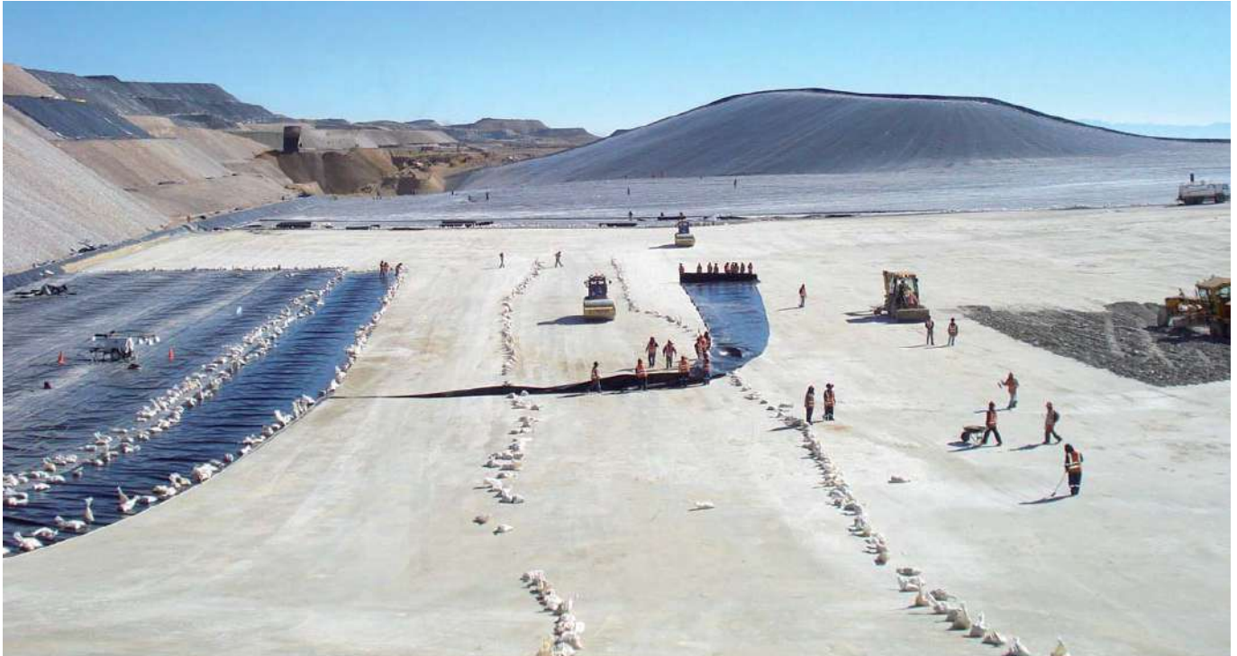
PAD DE LIXIVIACIÓN (FASE 2) MINA LAGUNAS NORTE, ALTO CHICAMA, BARRICK. CONTROL DE CALIDAD DE MOVIMIENTO DE TIERRA Y COMPACTACIÓN.
