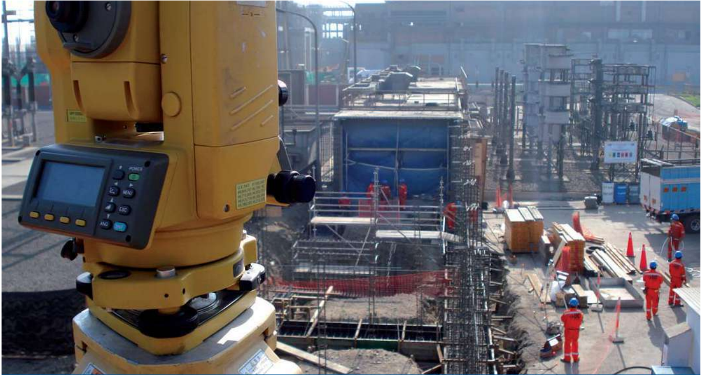
PROYECTO DE EXPANSIÓN 320 k. REFINERÍA DE ZINC DE CAJAMARQUILLA. CONTROL DE OBRAS.
