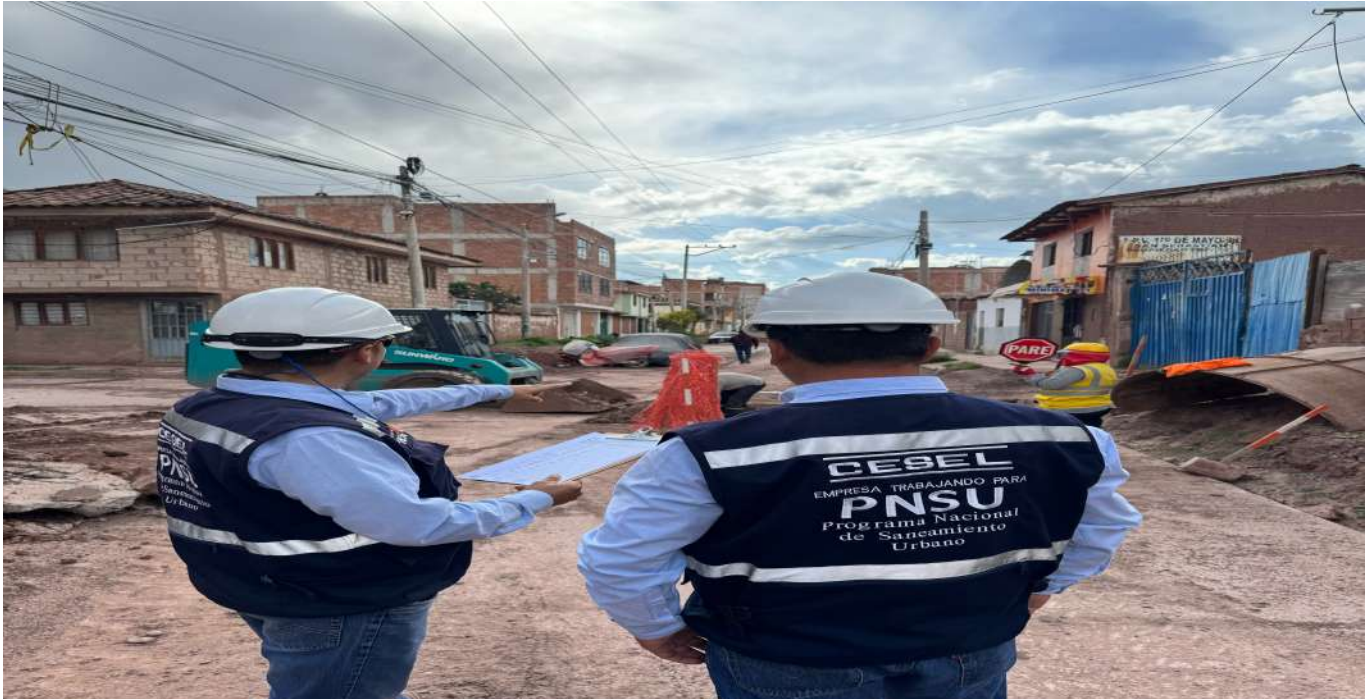
MEJORAMIENTO Y AMPLIACIÓN DEL SERVICIO DEL DRENAJE PLUVIAL - ETAPA 1: TANCARPATA . SUPERVISIÓN DE OBRA. CUSCO
